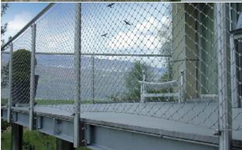
≤ Geografisch herausragende Positionen stellen an die Architektur besondere Anforderungen. Hier wird Wind zu Sturm, Schnee zur Eiswand und Sonne dehnt die Materialien. Statische Belastungen auf Druck und Zug sind die Folge der natürlichen Krafteinwirkungen. Für dauerhaften Schutz sorgen gerade hier die Edelstahlseilnetze X-TEND, denn sie leiten Kräfte ab und können immer wieder in ihre Ursprungsgestalt zurückkehren.
