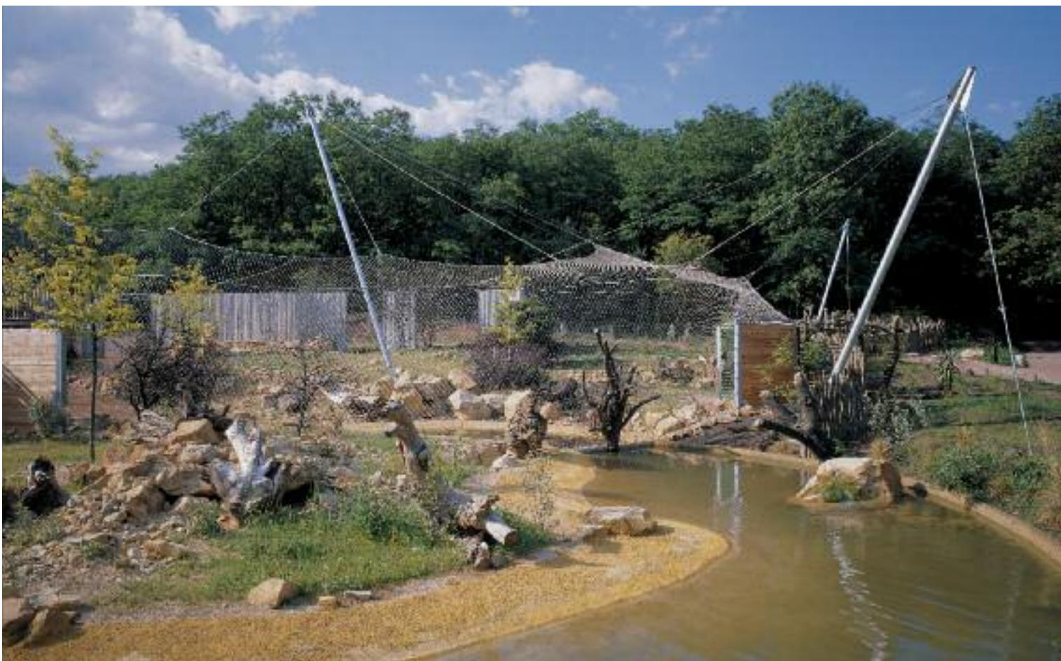
≤ Ein Mittelpylon und drei weitere außerhalb der Gehegefläche tragen den dreidimensional geformten X-TEND Zaun des nach oben offenen Reviers. So legen sich die Netzflächen völlig frei zwischen die horizontalen Ringseile, die über Abspannseile mit den Pylonen verbunden sind. Auf weitere Stahlprofile oder störende Stützen konnte zu Gunsten des uneingeschränkten Blicks verzichtet werden.
