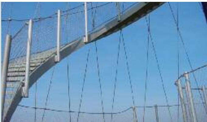
≤ Der 40 Meter hohe Turm der genialen Erfinder Schlaich Bergermann und Partner besteht aus einem Mast mit vorgespannter Seilstruktur, die durch intelligente Kräfteführung sich selbst, die Plattformen und Treppen hält. Zwei um 180 Grad gegeneinander angeordnete Stahltreppen erschließen das Wahrzeichen der Stadt Stuttgart, hier kommt das Edelstahl-seilnetz X-TEND für die Geländer zum Einsatz.
