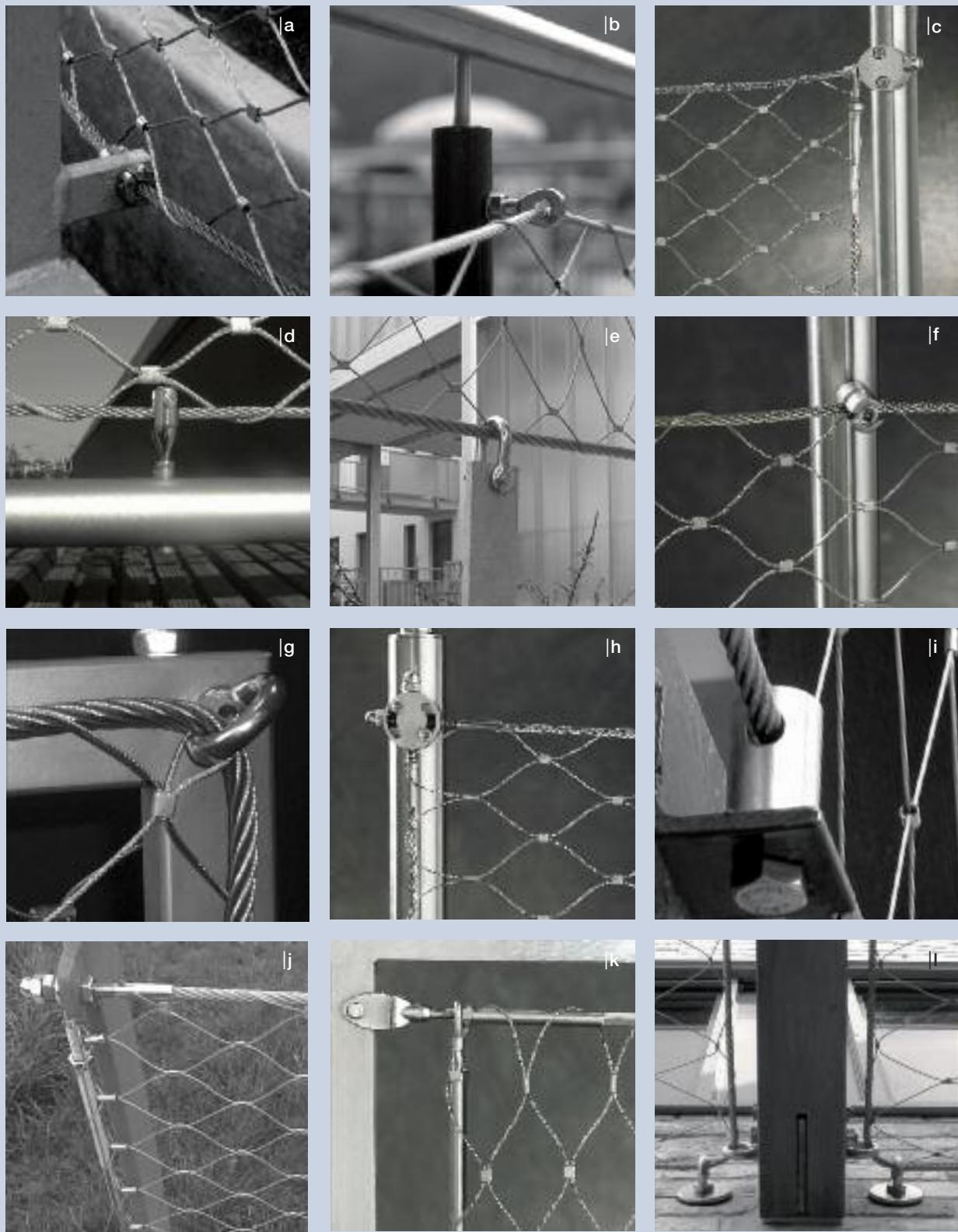
a–o Randseile und Befestigungen | Border cables and fixing points | Câbles de périphérie et fixations
