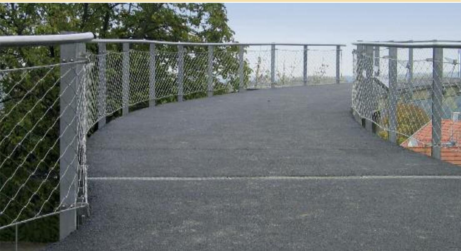
≤ Hubschrauberlandeplätze gehören mehr und mehr zum Standard für die Rettungsstellen von Krankenhäusern. In Mistelbach wird die runde Plattform von einem Netz aus X-TEND umringt, das maßgenau vorgefertigt und am Bau verspannt wurde. Die filigrane Konstruktion setzt sich fort als Geländerfüllung für Wege und Treppen.
