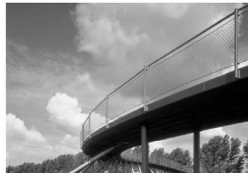
Vertikales Seilnetz, Seil-D. 1,5 mm
