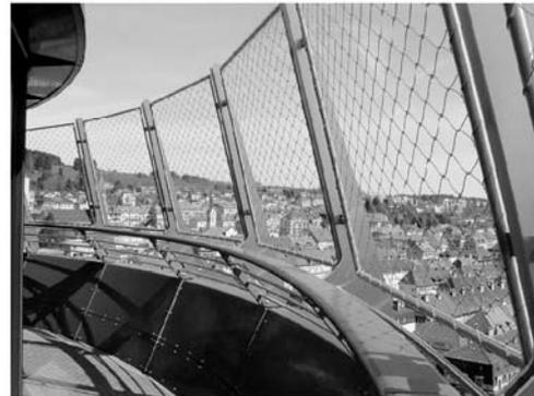
Vertikales Seilnetz, Seil-D. 2,0 mm
